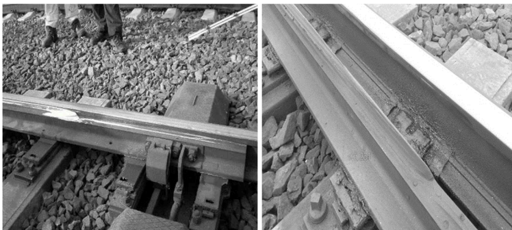
Obr V.3 - Ukázka jazyka s vodorovným odřezáním vlevo po zřízení nového začátku jazyka a vpravo po 2 letech provozu
