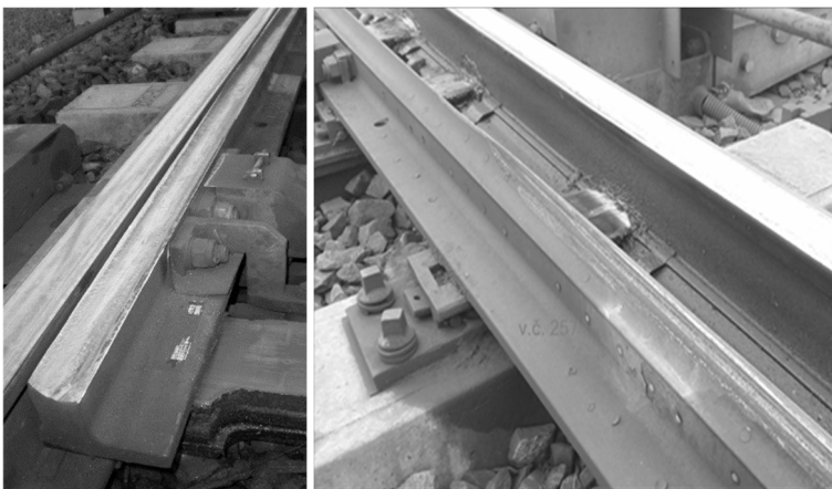
Obr V.2 - Ukázka jazyka s šikmým odřezáním vlevo po zřízení nového začátku jazyka a vpravo po 2 letech provozu
